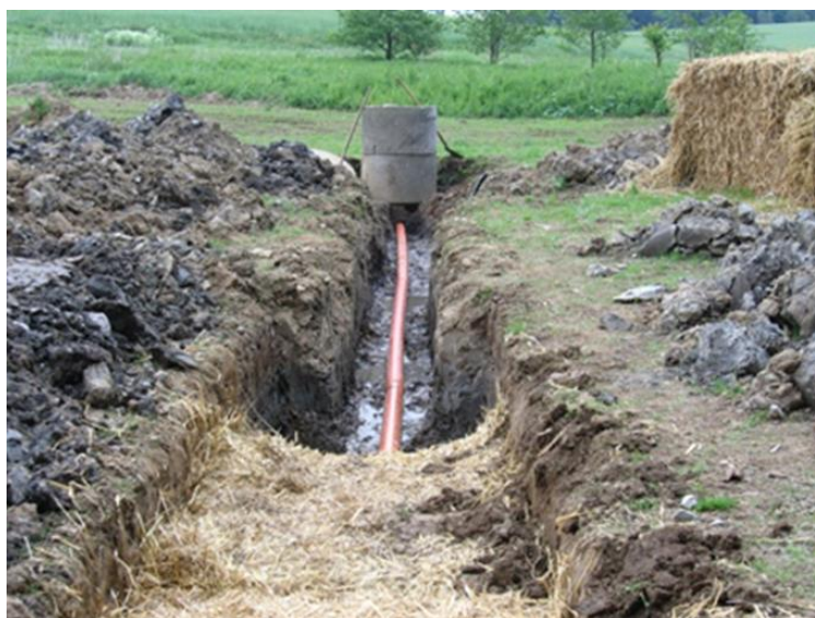
Obr. 5. Drenážní biofiltr na pokusné lokalitě Černičí
