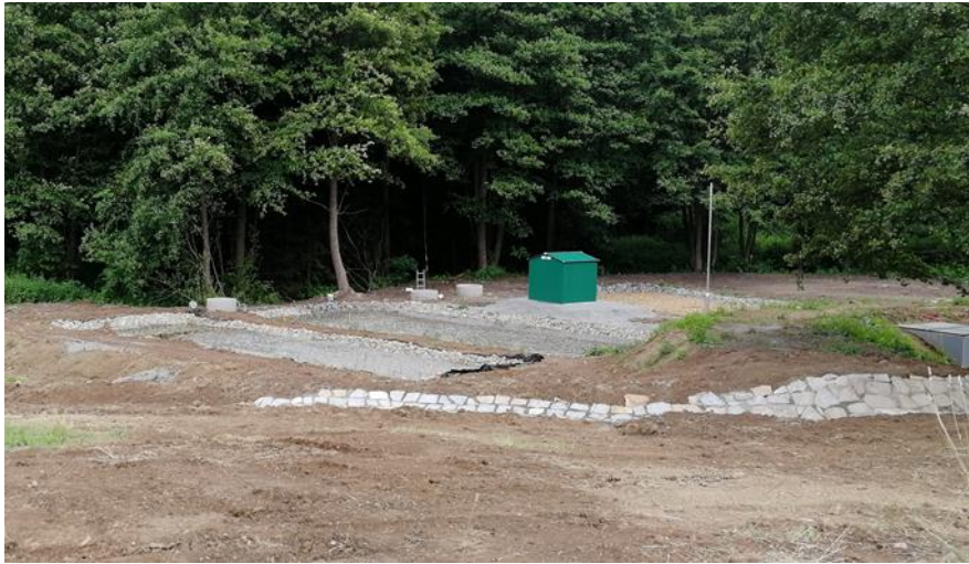
Obr. 4. Pohled na nově založený pokusný umělý mokřad (čerstvě zasazené rostliny)
